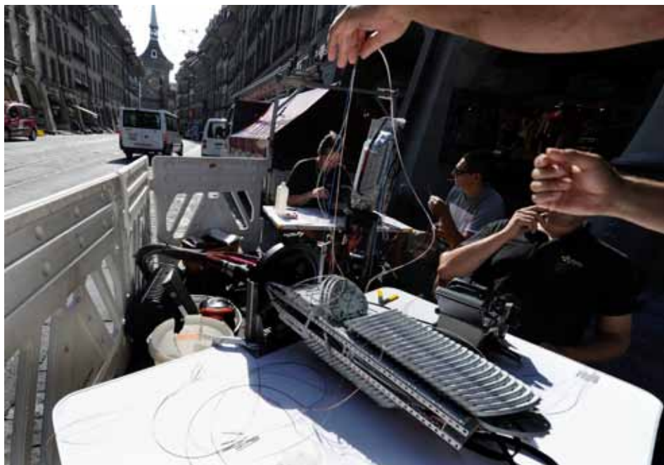
Techniker spleissen Glasfasern auf einer Strassenbaustelle in der Altstadt Bern. Durch den Ausbau des Hochleistungs-Glasfasernetzes erhalten immer mehr Kunden Anschlüsse mit Übertragungsraten im Gigabitbereich. Foto: Keystone
